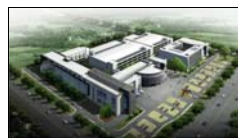
中金数据公司北京、华北数据中心 19XR1200(10kV)*10/19XR1500*9
