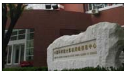
中科院网络信息中心数据中心 19XR(10kV)*3
