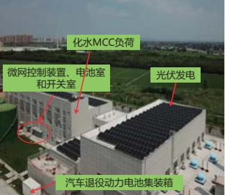
**平台组成:**由屋顶光伏 (168kW)、电池储能 (300kW/292kWh)、退役汽车动力电池 (50kW /150kWh) 以及相关配套的电气及智能微网控制设备组成，选取化学制水段组成微电网。
